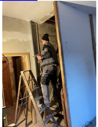
Einbau der Tür zum Spitzboden
